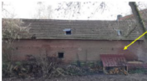
Anciennes étables façade nord
