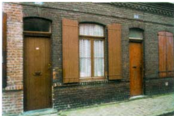
106, rue Nabuchodonosor. Baies cintrées, appareillage de la brique en plate-bande. Simplicité de la modénature: cordons et corniche à modillons.
