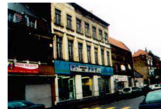
127, Grande Rue. Edifice commercial à R+2 comprenant sept travées. Surdimensionnement des percements du rez-de-chaussée par rapport aux baies d'étage.
