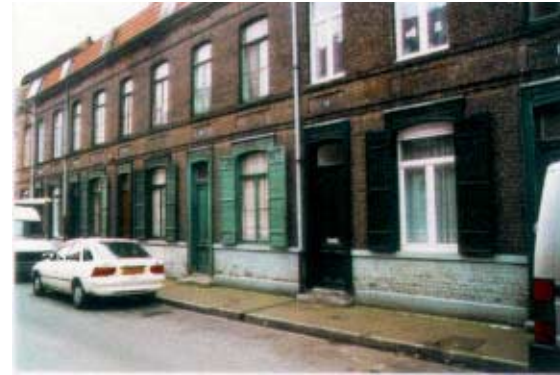
12-24, rue Delezenne. Groupe de maisons de deux travées. Simplicité de la modénature soulignant les niveaux et la composition par travée. Encadrements en bois des portes et fenêtres à rez-de-chaussée.
