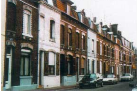
103-125, rue Jouffroy. Maisons ouvrières à R+1 avec mixité de matériau. Groupe de maisons identiques sur la totalité du front de rue de l'îlot.
