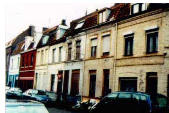
32-36, rue Basse Masure. Choque de maisons ouvrières enduites à deux ou trois travées. Altération généralisée de la maçonnerie enduite : enduit pioché, mise en peinture, enduit ciment rapporté.
