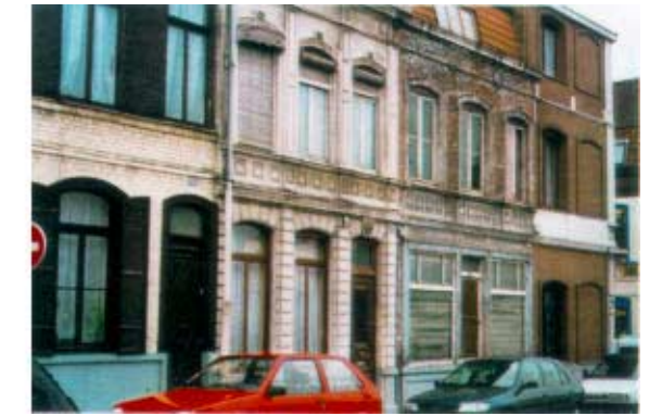
84-86, rue Jean Moulin. Maison à trois travées. Maçonnerie enduite. Insertion de la devanture commerciale dans la composition de la façade.
