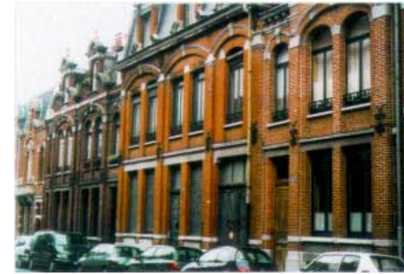
39-43, rue de Dammartin. Ensemble de maisons de maître. Sablage de la brique au 43. Mise en peinture de la brique au 41.
