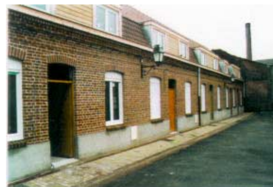
26bis, cour Vromant. Opération de réhabilitation en courée. Sablage de la brique et enduit ciment rapporté en soubassement. Menuiseries plastiques.
