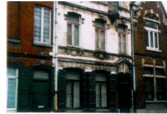
139, rue Jean Moulin. Maison à trois travées. Maçonnerie enduite. Encadrements en bois de la porte et des fenêtres à rez-de-chaussée. Volets persiennés.
