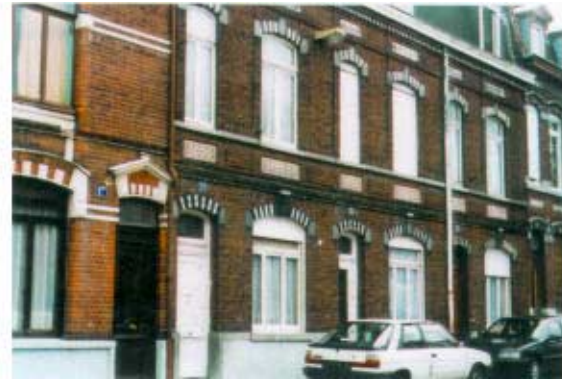
19-23, rue de Valmy. Groupe de maisons de deux travées. Mixité des matériaux: soubassement en pierre, brique émaillée et pierre de l'appareillage en plate-bande des baies cintrées, motifs de céramique en allège.
