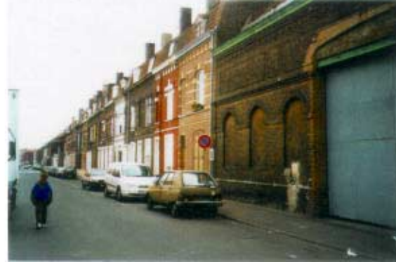
30-60, rue de Bavai. Maisons ouvrières à R+1 avec unicité de matériau. Groupe de maisons identiques sur un large front de rue.
