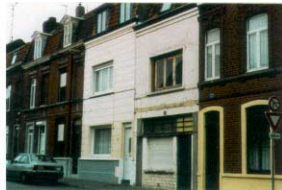
51-53, rue de Bouvines. Groupe de maisons à deux travées. Suppression d'une travée d'étage et modification des proportions des fenêtres. Matériaux rapportés sur la maçonnerie en brique.
