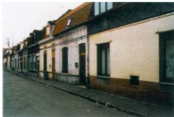
2-12, rue Lafayette. Maisons ouvrières à rez-de-chaussée. Altérations liées à l'initiative individuelle. Modifications des rythmes formés par les groupes de maisons identiques.
