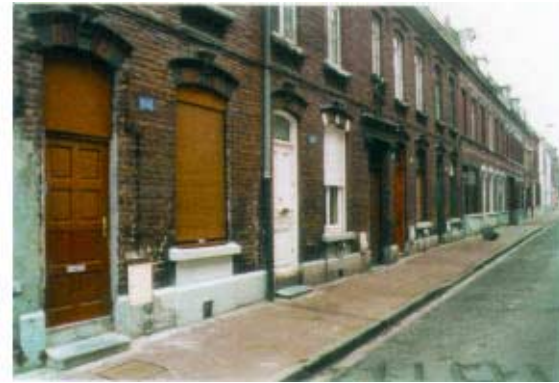
92-108, rue Franklin. Groupe de maisons ouvrières à R+1 avec mixité de matériau. Utilisation de la pierre en soubassement et appui de fenêtre.
