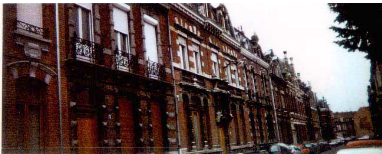
3-41, rue Mimerel. Front de rue constitué d'une succession de maisons de maître.
