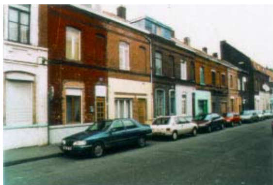
251-261, rue Jules Guesde. Maisons ouvrières à R+1 avec unicité de matériau. Banalisation du front de rue par la répétition des altérations à rez-de-chaussée.
