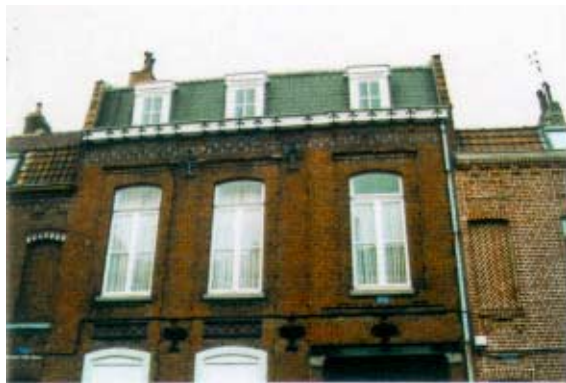
108, rue La Fontaine. Maison de maître de trois travées entre limites séparatives. Accès au jardin en fond de parcelle par une porte cochère.
