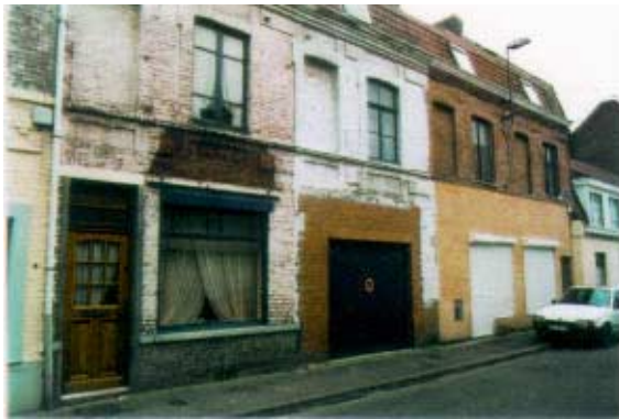
278-282, rue Jules Guesde. Groupe de maisons à deux travées. Modification des rythmes et des proportions des ouvertures en rez-de-chaussée: élargissement des fenêtres et création de portes de garage.
