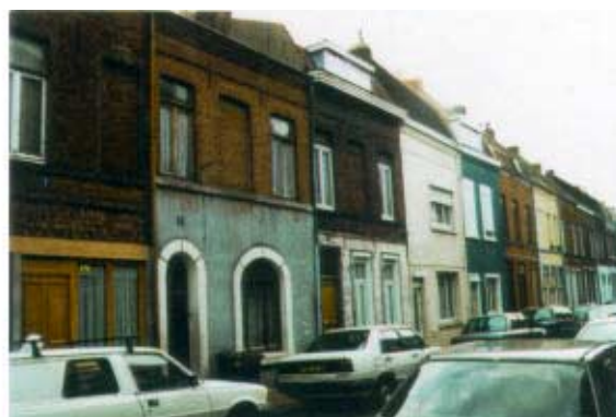
1-9, rue Saint-Eluthère. Maisons ouvrières à R+1 avec unicité de matériau. Perte de lisibilité de l'unité architecturale de chaque façade et des groupes de maisons identiques.
