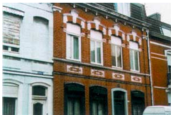
131, rue Jean Moulin. Maison à quatre travées. Menuiseries plastiques et suppression des impostes vitrées des fenêtres d'étage.
