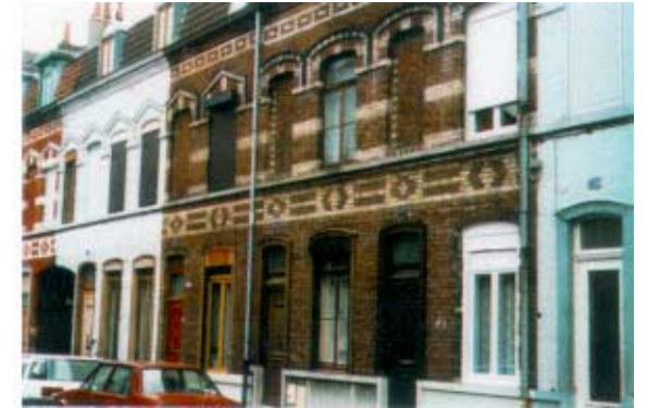
55-57, rue Sainte-Thérèse. Groupe de maisons de deux travées. Enrichissement de la modénature par l'association de la brique blanche et de la brique rouge.
