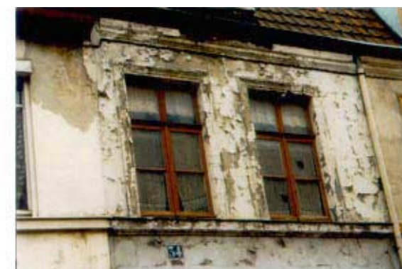
34, rue du Collège. Maçonnerie enduite. Encadrements des baies, bandeau d'étage et corniche en plâtre.
