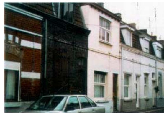
30-36, rue Courbet. Groupe de maisons à deux travées. Surélévation de l'étage de comble. Élargissement des fenêtres à rez-de-chaussée.
