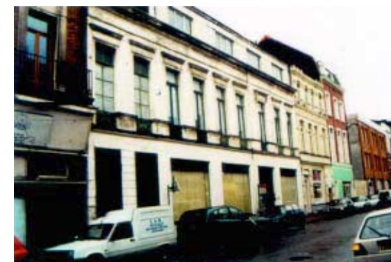
43-45, Grande Rue. Edifice commercial sur un parcellaire très large. Modification de la volumétrie par surélévation.
