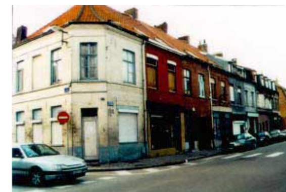
37-39, rue de Tourcoing. Choque de maisons ouvrières de deux travées. Altération de l'enduit et de la proportion des baies à rez-de-chaussée.
