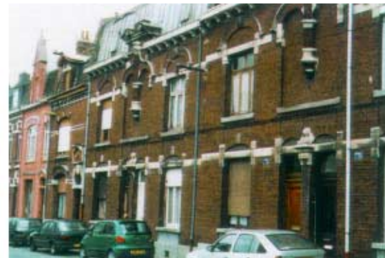
69-73, rue de Valmy. Maisons ouvrières à R+1 avec mixité de matériau et maisons de ville. Mixité typologique à la périphérie du quartier.
