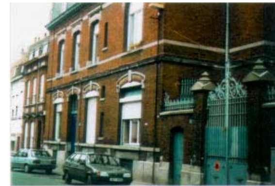
1, rue Ma Campagne. Suppression des impostes vitrées. Remplacement des menuiseries bois par des menuiseries plastiques. Adjonction de volets roulants.
