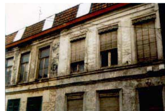
5-7, rue des Champs. Choque de maisons ouvrières à trois travées. Rythmes horizontaux et verticaux de la composition de la façade soulignés par la modénature.
