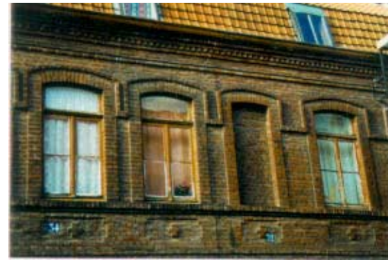
32-34, rue Saint-Amand. Rythmes verticaux et horizontaux de la composition des façades soulignés par la modénature: cordons, corniche, encadrements des baies et motifs décoratifs en allège.
