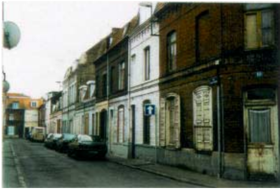
2-32, rue Casimir Périer. Groupes de maisons ouvrières à rez-de-chaussée et à R+1 avec unicité de matériau. Opération de lotissement amorcée à la fin du 19e siècle.
