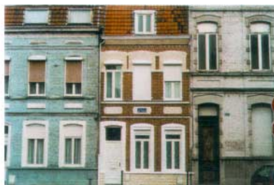
143, rue du Coq Français. Maison à trois travées. Sablage de la brique et matériaux rapportés en façade: soubassement et encadrements des baies d'étage. Menuiseries plastiques et volets roulants.
