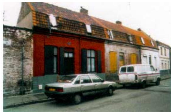
11-15, rue Mons. Groupe de maisons à trois travées. Régularité des percements et sobriété de la modénature.
