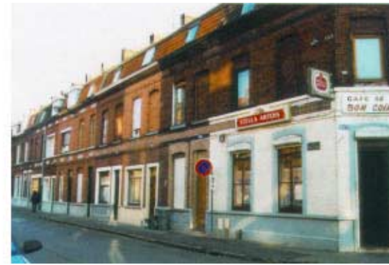
203-211, rue Pierre de Roubaix. Maisons ouvrières à R+1 avec mixité de matériau. Régularité des rythmes verticaux formés par les groupes de trois ou quatre maisons identiques.
