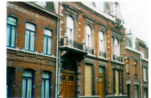
50, rue de Valmy. Suppression des impostes vitrées des baies d'étage. Remplacement des menuiseries bois par des menuiseries plastiques à l'étage.
