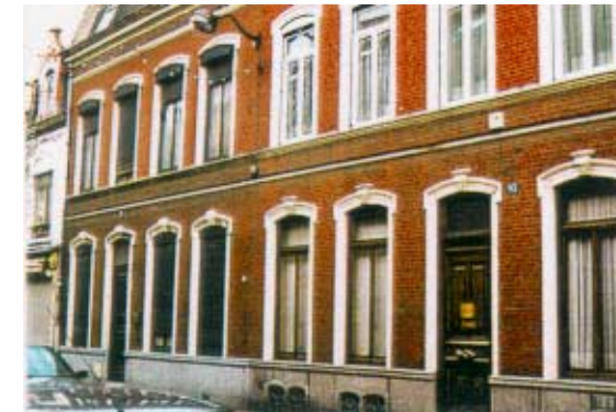
93-95, rue de Lannoy. Maison à quatre travées. Maçonnerie en brique non enduite. Soubassement en grès. Encadrements des baies, bandeau d'étage et corniche en plâtre.
