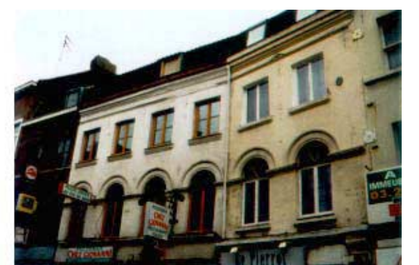
15-19, rue du Vieil Abreuvoir. Maisons à deux travées. Superposition de baies cintrées et de baies plus sobres à linteau droit.
