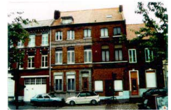
212-214, rue de l'Alma. Choque associant maisons ouvrières à deux et trois travées. Altération des baies à rez-de-chaussée : modification des proportions.
