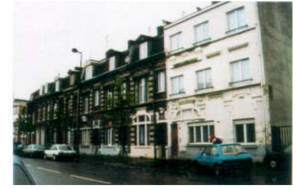
8-20, boulevard de Beaurepaire. Groupe de maisons de deux travées. Surélévation de l'étage de comble. Modification du rythme des travées et de la proportion des fenêtres.
