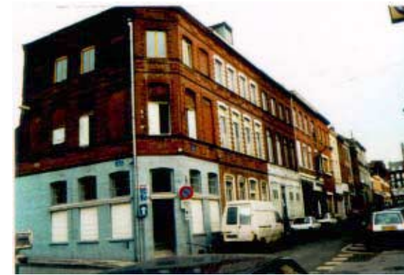
Angle rue de l'Alouette - rue de l'Espérance. Choque de maisons ouvrières à deux étages et quatre travées. Altération des percements à rez-de-chaussée sur l'angle : modification de la hauteur des fenêtres.
