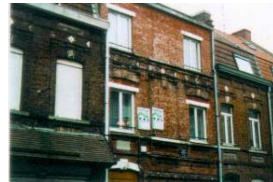
81, rue de Bouvines. Groupe de maisons à deux travées, et travée d'accès à la courée en coeur d'ilôt. Surélévation de l'étage de comble. Modification de la hauteur des fenêtres.
