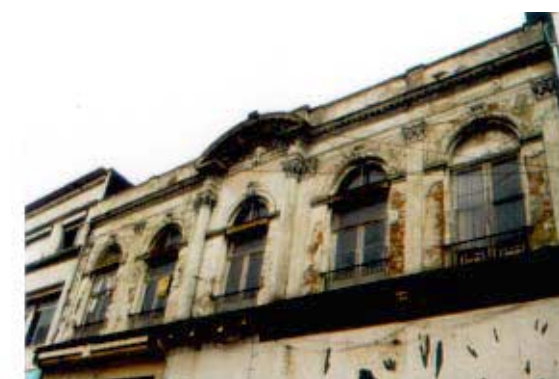
31, Grande Rue. Façade d'inspiration classique associant colonnes engagées, pilastres, fronton. Eventrement complet de rez-de-chaussée par la devanture commerciale.
