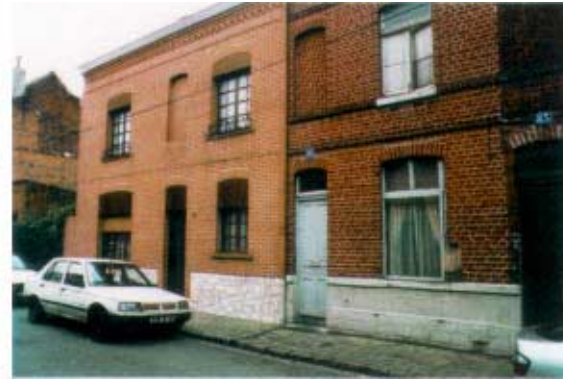
79, rue Nabuchodonosor. Matériaux rapportés sur la façade: brique de parement en partie courante et pierre en soubassement. Suppression des impostes et adjonction de volets roulants. Porte et fenêtres à petits carreaux.
