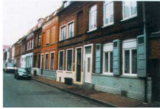
15-29, rue Saint-Eleuthère. Front de rue constitué de maisons ouvrières à R+1 avec unicité de matériau. Rythmes réguliers des groupes de trois ou quatre maisons identiques.
