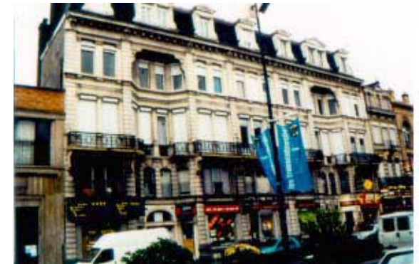
45-51, avenue Jean Lebas. Composition symétrique et ordonnée de l'élévation. Pérennité de l'unité architecturale des façades.
