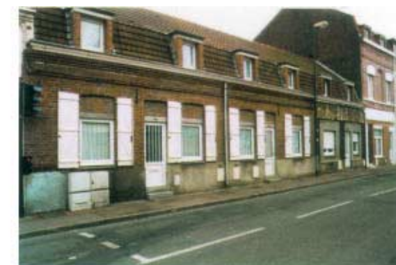
162-166, rue Jules Guesde. Opération de réhabilitation en front de rue. Suppression des impostes vitrées. Enduit ciment rapporté en soubassement. Menuiseries plastiques.
