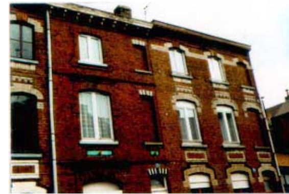
24-28, rue de la Perche. Choque de maisons ouvrières jouant sur l'alternance de combinaisons de matériaux dans la modénature des façades.
