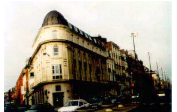
Angle avenue Jean Lebas - rue du général Sarrail. Bâtiment d'angle marquant l'entrée de l'avenue coté Grande Place, par un dôme en ardoise en toiture.
