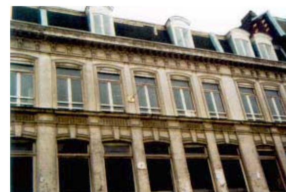
4, Grande Rue. Façade présentant une modénature simple et sobre qui vient s'enrichir d'inscriptions en plate bande. Remplacement au premier niveau des menuiseries d'origine bois par des menuiseries métalliques.
