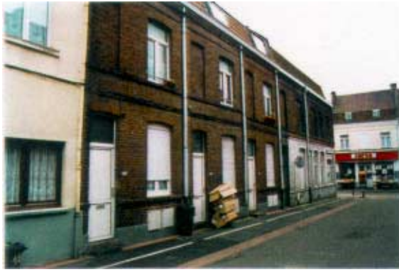
6-10, rue Desaix. Opération de réhabilitation en front de rue. Remplacement des menuiseries bois par des menuiseries plastiques. Adjonction de volets roulants en rez-de-chaussée.
