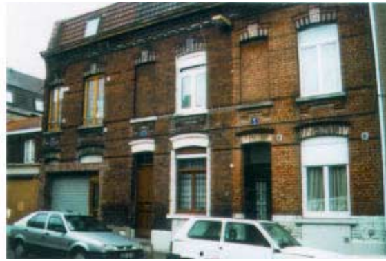
1-5, rue la Fontaine. Groupe de trois maisons ouvrières à R+1 avec mixité de matériau.
