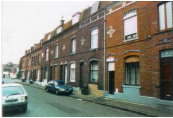
54-66, rue de Mons. Front de rue constitué de maisons ouvrières à R+1 avec mixité de matériau. Succession de groupes de quatre ou cinq maisons identiques.
