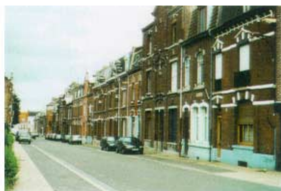
51-73, rue de Valmy. Maisons de maître. Pérennité des dispositions architecturales anciennes. Altérations ponctuelles à caractère plus réversible.
