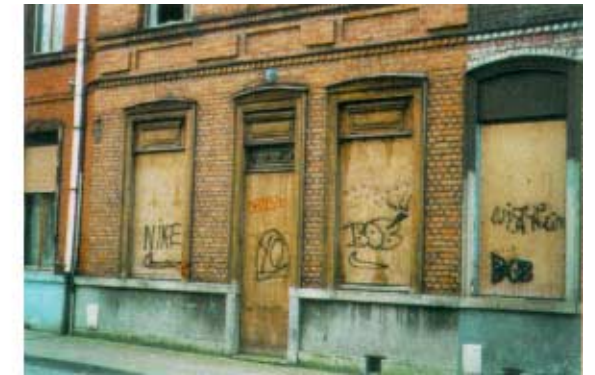
2bis, rue Ma Campagne. Maison à trois travées. Encadrements en bois de la porte et des fenêtres du rez-de-chaussée. Impostes pleines.
