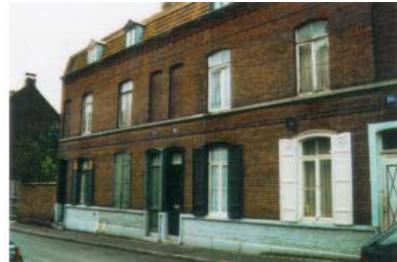
68-72, rue de Bouvines. Maisons ouvrières à R+1 avec unicité de matériau. Séquences régulières formées par des groupes de trois ou quatre maisons identiques.
