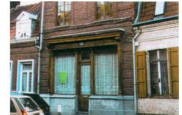
131, rue Jules Guesde. Maison à deux travées. Maçonnerie en brique non enduite. Soubassement en grès. Ancienne devanture commerciale en bois.
