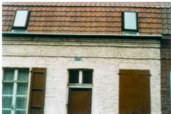
135, rue Jules Guesde. Porte pleine et fenêtres à grands carreaux, et à impostes vitrées. Volets composés de larges planches verticales confortées par des traverses.
