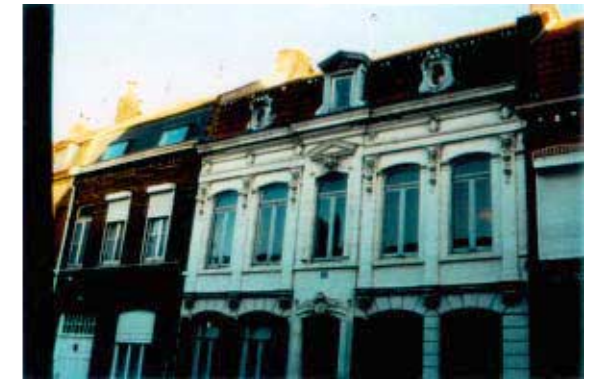
40, rue de la Lys Maison de ville présentant une modénature d'inspiration classique : pilastres, entablement, encadrements des baies, mascarons.
