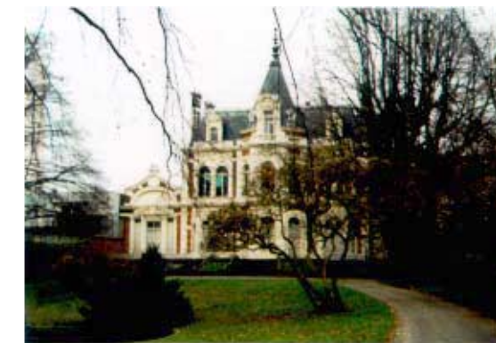
Ancien Hôtel Catteau. 45, rue du Grand Chemin. Façade sobre sur jardin présentant un avant-corps central.
