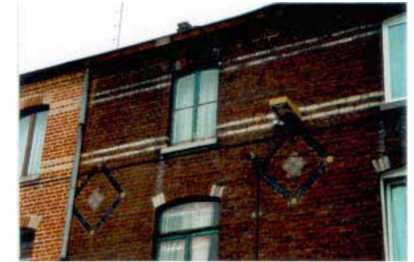
27, rue Heilmann. Mixité des matériaux : association des couleurs de la brique émaillée et de la céramique dans l'appareillage.
