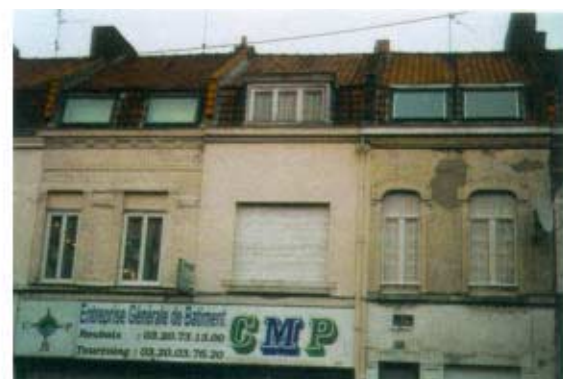
191, rue de Lannoy. Groupe de maisons à deux travées. Modification du rythme des travées à l'étage. Éventrement complet du rez-de-chaussée par la devanture commerciale.
